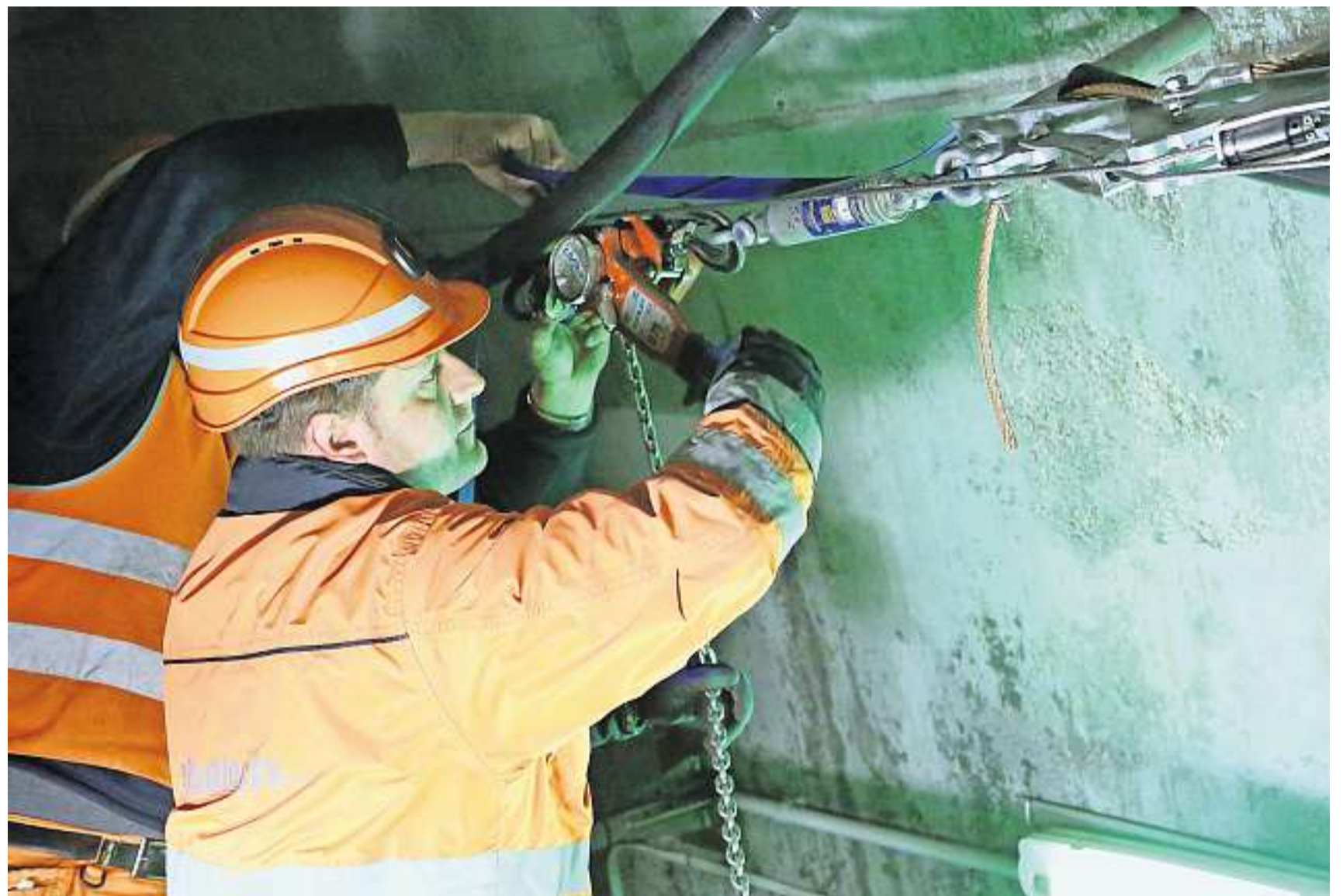
Das strahlende Kabel wird auf maximal 100 Kilogramm gespannt.
