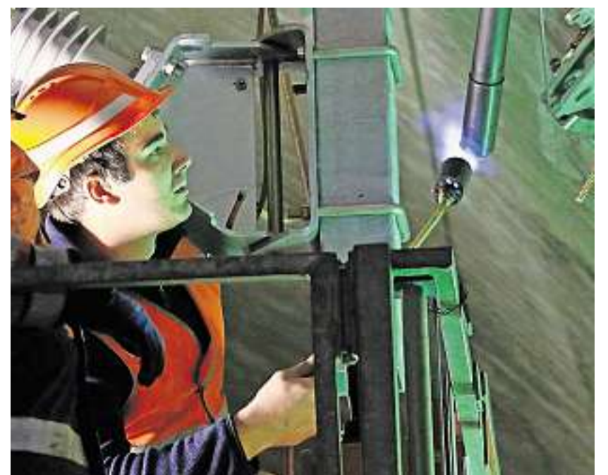
Provisorisches Verschliessen des Kabels zum Schutz gegen Feuchtigkeit.
